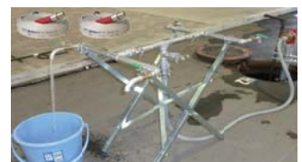
消火栓を活用した応急給水
